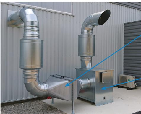
Die **Filter** sind aus galvanisiertem Blech gefertigt und auf Teleskopschienen montiert. Mit Hilfe eines optionalen Wartungsanzeigers lässt sich der Zustand der Filter überwachen.
