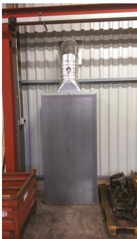
Mechanische Luftverteilerkammern von **ENGMAR** dienen der durch Ventilatoren unterstützten Frischluftzufuhr zum Ausgleich von Absauganlagen.
