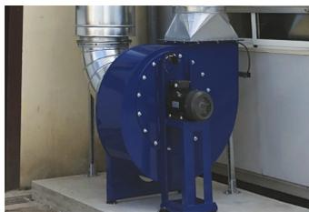
Die eingesetzten Ventilatoren vom Zentrifugal-Typ verfügen über umgekehrte Rotorenblätter, die speziell auf die Absaugung von staubversetzter Abluft optimiert sind.
