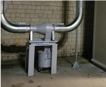
Der Funkenvorabscheider scheidet nach dem Zyklon-Prinzip und scheidet die größten Schmutzpartikel bzw. brennende Partikel ab. Bestehend aus einem Metallgestell, dem Zyklon mit Prallblech, sowie einem Eimer für die abgeschiedenen Partikel.
