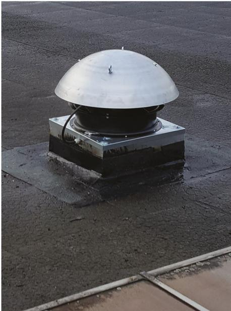
Für die Be- und Entlüftung von Industrie- und Fertigungsgebäuden bieten sich Dachhauben an. Die Dachhauben für horizontalen Luftstrom TJH bestehen aus Aluminium. Die Dachhauben für vertikalen Luftstrom TJV bestehen aus verzinktem Stahl. Bezüglich passender Dachdurchführungen beraten wir Sie gern. Bitte geben Sie uns hier die Dachneigung an.
